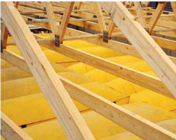
Bild 10 Air Cushion System von Airtec (Foto: Airteksafety)
